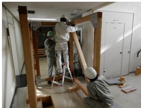
写真-1 作業状況
