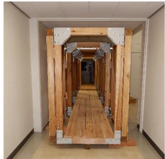
写真-3 完成した木製ハウトラス橋
