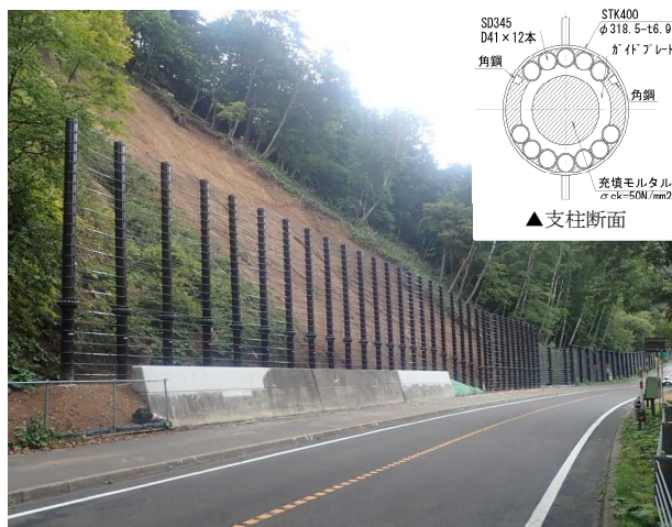
写真-1 土砂堆積用支柱フェンス
