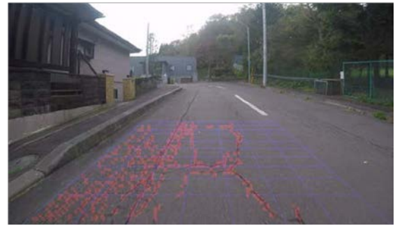
図-1 CNN によるひび割れ検出の例
