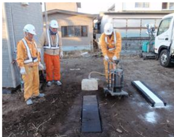
図-1 路面標示材塗布の様子
