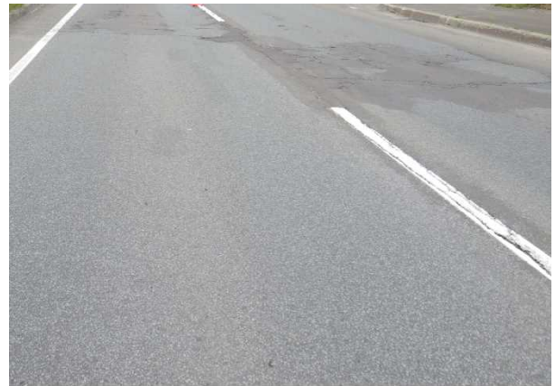
写真-2 密粒13F 再生50%工区
