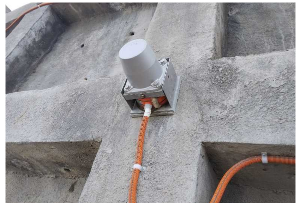
写真-2 荷重計の設置状況
