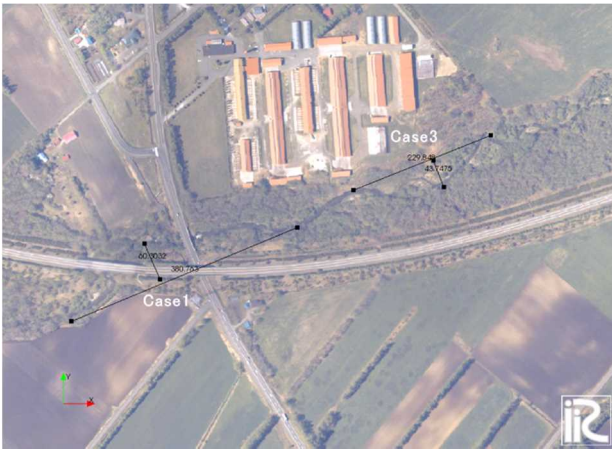
図-3 十勝川水系小林川に架かる橋梁（図-1）の被災前の状況と河川線形
