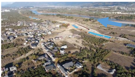
写真-6 長野県穂保地区破堤箇所の状況 (2019年11月8日撮影)
