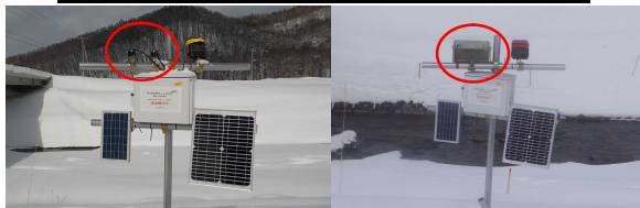
図-10 ライト設置状況（左：低出力、右：高出力）
