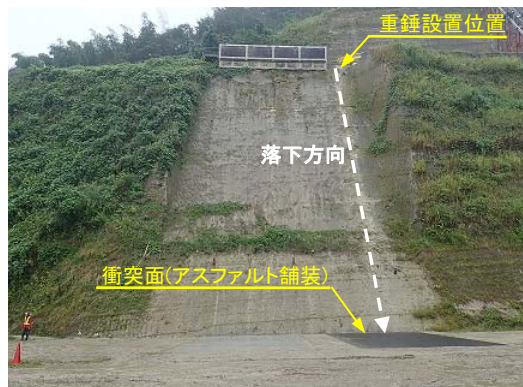
写真-2 実験場斜面(正面)
