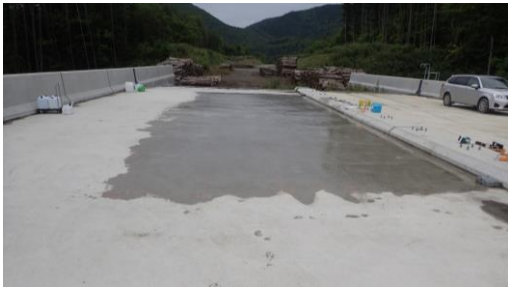
写真-1 散水状況
