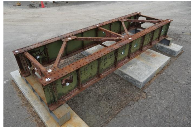
図-7 旧万川橋梁
