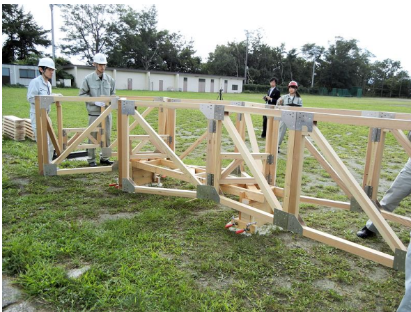
写真-5 架設台上で橋を展開
