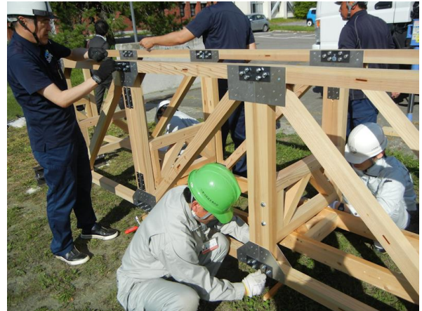
写真-6 連結板の取り付け
