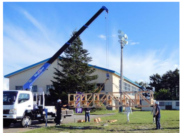
写真-7 一括架設
