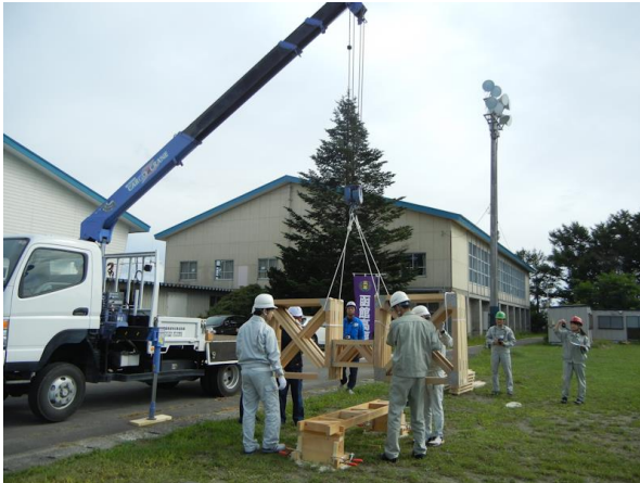
写真-4 架設台上に折り畳み橋を降ろす作業
