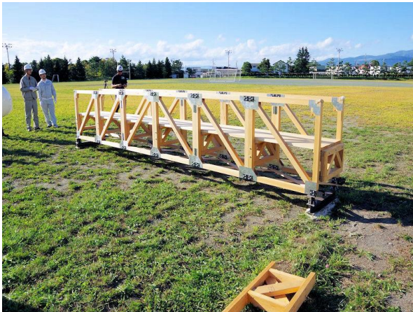
写真-8 架設完了
