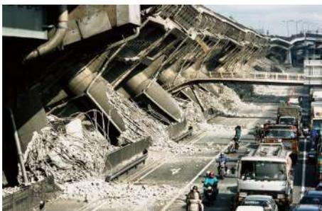
写真-1 阪神高速道路3号線の倒壊したピルツ橋脚<sup>2)</sup>
