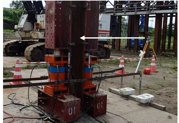
写真-2 レベル計測による引抜き量の確認
