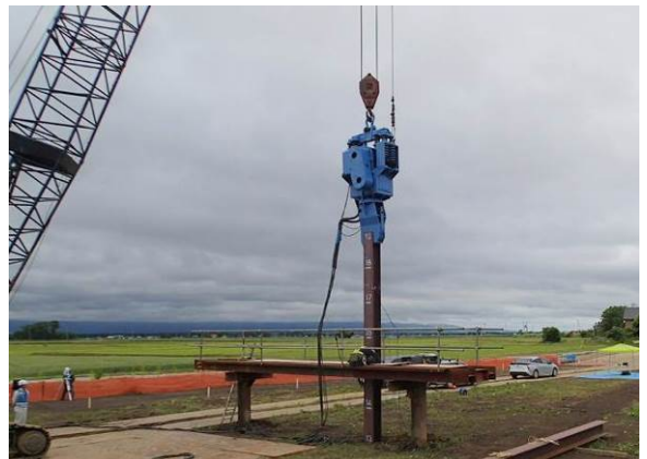
写真-3 仮設杭打ち込み状況
