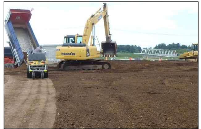
図-3 盛り土の敷き均し
