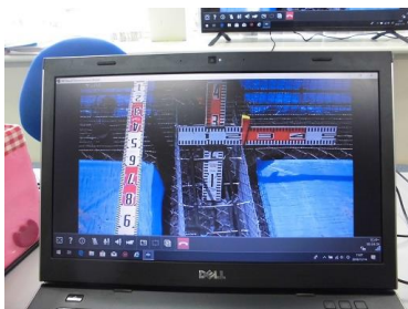
写真5 遠隔臨場による社内検査
