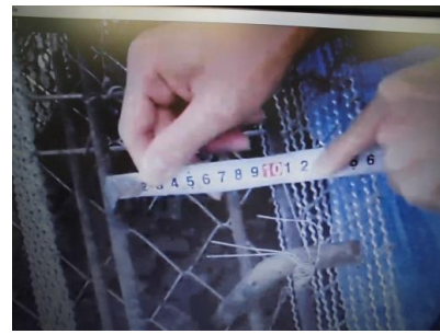
写真6 遠隔臨場による社内検査
