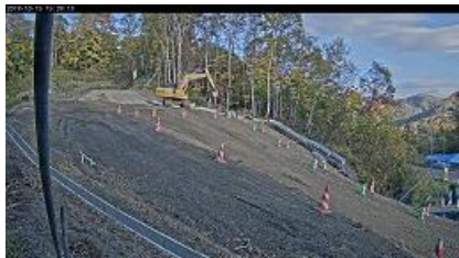
図7 側面からの掘削作業
