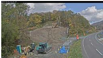
図8 下端部からの掘削運搬作業
