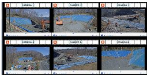
定点での施工状況比較
