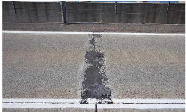
写真-1 アスファルト混合物による補修箇所の剥離状況
