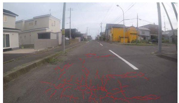
図-4 ひび割れスケッチ画像 (一例)
