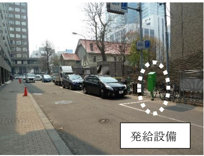
写真-1 発給設備
