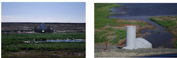
図 1 ベンチレーション
