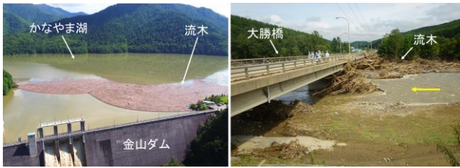
図-3 2016 年洪水時のかなやま湖の流木流入状況 左) ダム堤付付近(2016 年 9 月 2 日撮影、開発局提供) 右) ダム上流の大勝橋(2016 年 9 月 3 日撮影、調査団)
