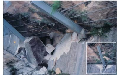
写真-1 支柱基礎部の損傷例
