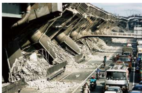
写真-1 阪神高速道路3号線の倒壊したピルツ橋脚 2)
