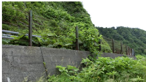
写真-1 試験材料採取箇所（落石防護柵）
