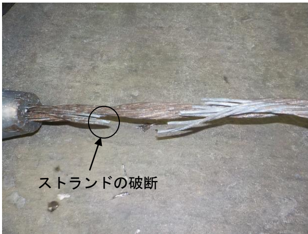
写真-6 試験後の状況（落石防護柵 1-1）
