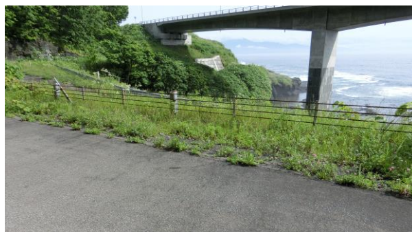
写真-2 試験材料採取箇所（ガードケーブル）
