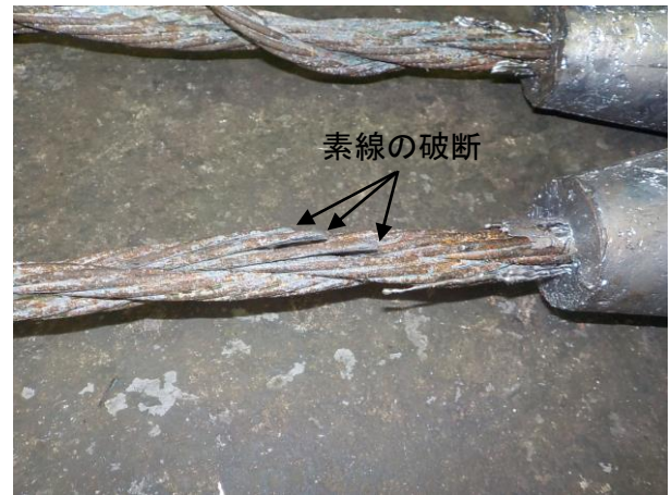
写真-7 試験後の状況（落石防護柵 1-3）
