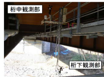
写真-4 桁下、桁中観測部
