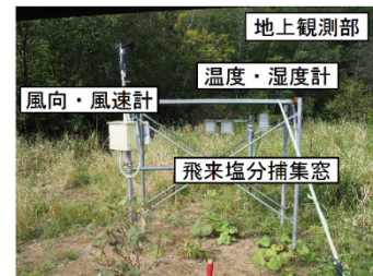
写真-3 地上観測部と観測機器
