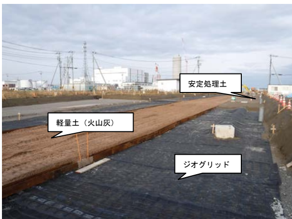
写真—1 施工詳細 (ジオグリッド、軽量土、安定処理土)
