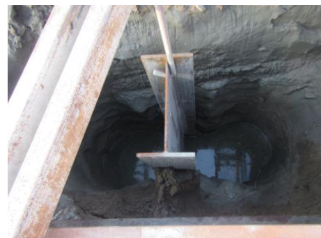
写真—4 H形鋼芯材建て込み完了状況
