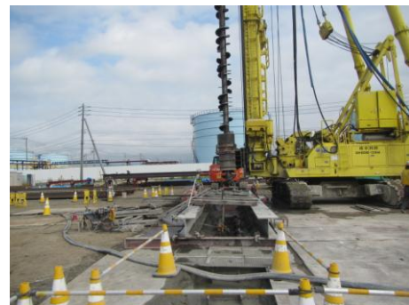
写真—3 SMW 施工状況
