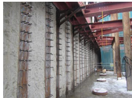
写真—1 スタッドジベル取付状況
