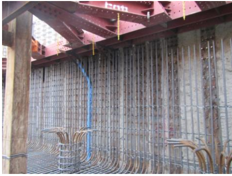
写真—2 スタッジベル取付後の鉄筋組立状況
