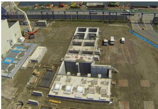
写真—5 ポンプ室完成状況
