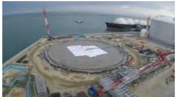
写真-4 打設完了 (14日 5時 30分)
