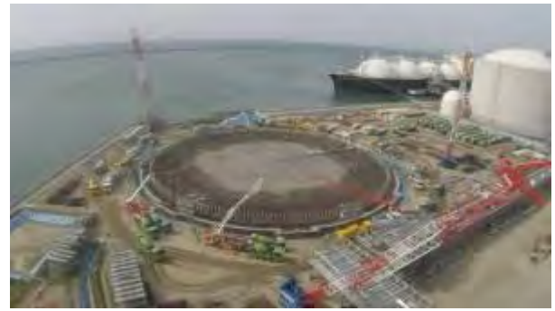
写真-2 打設状況 (13日 15時)
