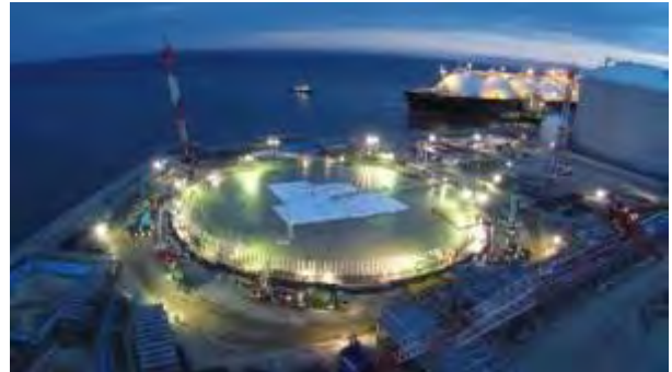
写真-3 打設状況 (14日 4時)
