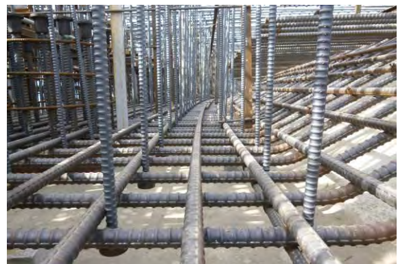
写真-5 せん断補強筋（機械式定着）
