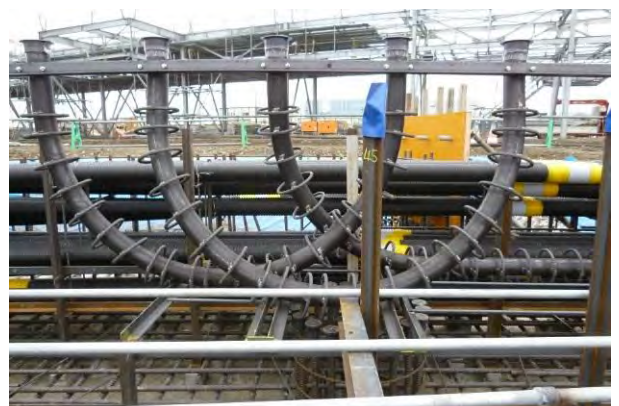
写真-2 PC シースおよび架台設置状況
