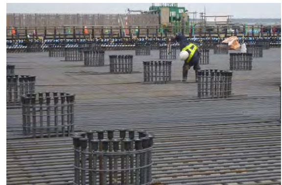
写真-6 杭頭補強筋（機械式定着）
