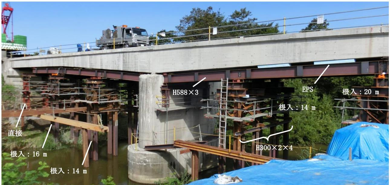
図-4 ベントおよび縦桁
