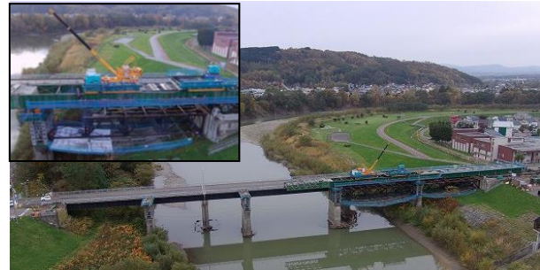
写真3 ジブクレーンによる桁解体および架設桁解体
