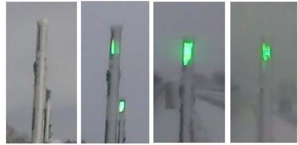
既設15度傾斜 ヒーター仕様 写真-6 1 2 月 3 0 日 1 4 時の状況
