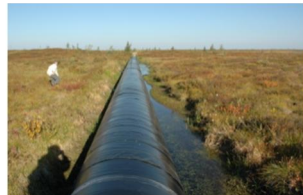
図 1-2：構造物の被害
