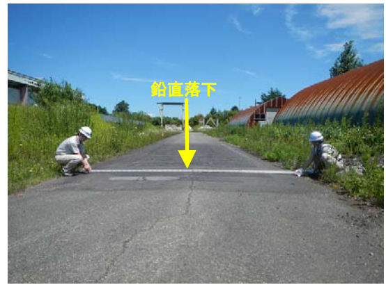
落下対象：(a) アスファルト
