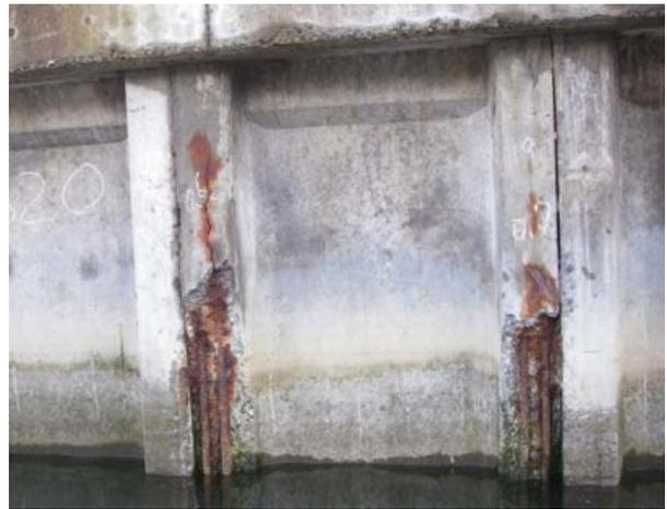
写真-1 コンクリート矢板の劣化状況<sup>1)</sup>
