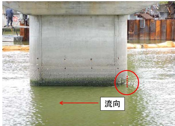
写真-2 ピア上流側部分の欠損 (2017年7月31日)
