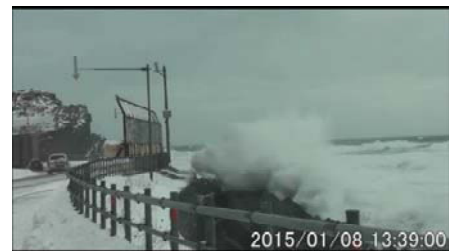
図-5 2015/01/08 に撮影された護岸越波の様子
