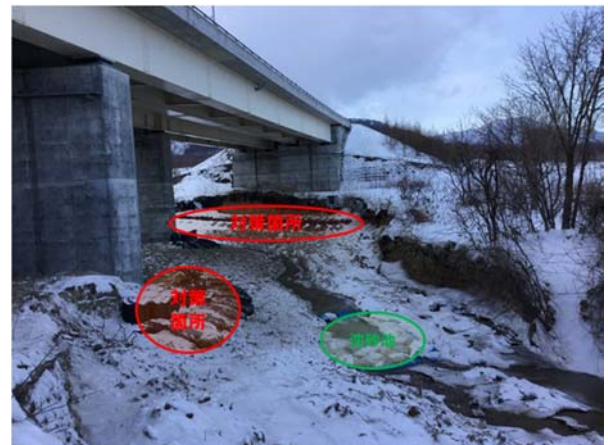
写真-5 応急対策と濁水処理
