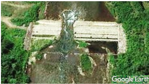
図-4 戸蔭別川第5号床固工
