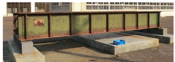
図-1 実験橋梁写真(G1 桁側)
