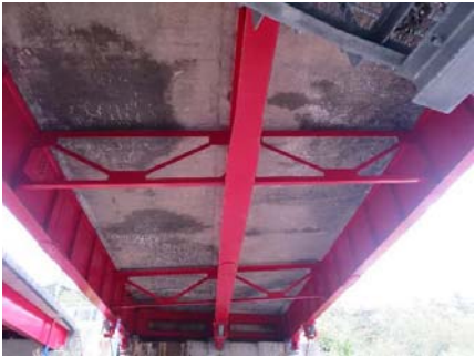
写真－1 床版下面の状況
