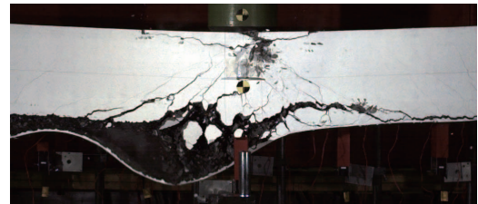
写真-2 実験時の AFRP シート剥離状況 ( H = 3.0 \text{ m} )
