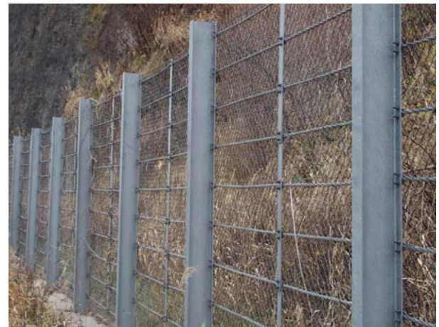
写真-1 従来型落石防護柵
