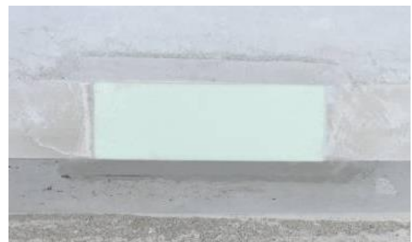
写真-1 蓄光材（エポキシ系樹脂モルタル）の接着状況
