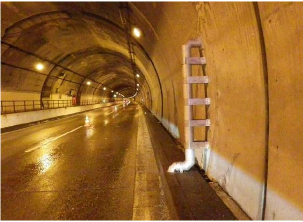
写真－4 追越側排水管設置状況
