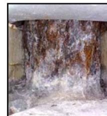
写真-5:定着部の腐食状況
