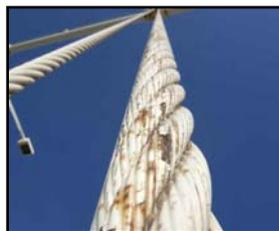
写真-4:一般部の腐食状況
