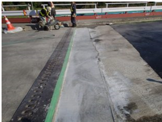
写真-3 補修後状況 (A1 側)
