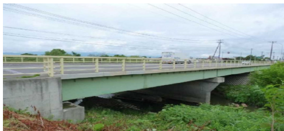
写真-1 橋梁側面全景
