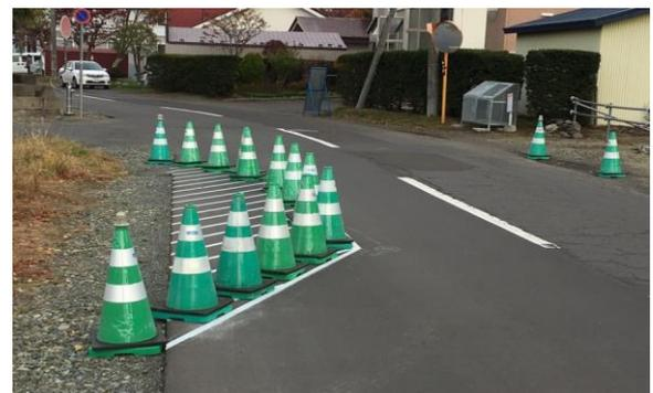
図-2 交通速度抑制を促す狭さく区間
